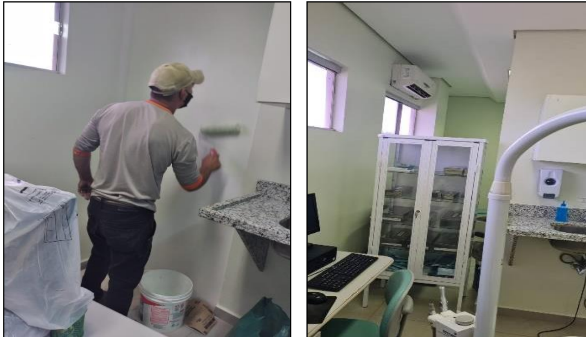
Figura 7. Instalação e pintura de parede em gesso entre consultórios 3 e 4. Rio Branco, Acre. 2021.
