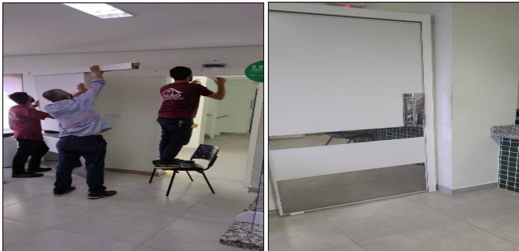
Figura 8. Adequação de portas de correr (entrada e sala 2). Rio Branco, Acre. 2021.
