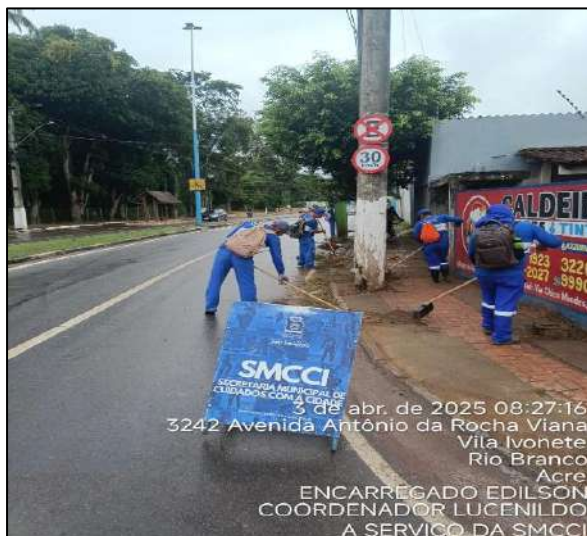
Imagem 03: Avenida Antônio da Rocha Viana
