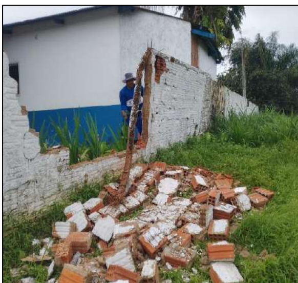
Imagem 1 - Muro do Cemitério São Francisco
