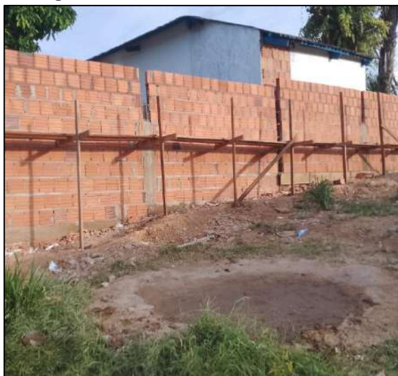
Imagem 3 - Muro do Cemitério São Francisco
