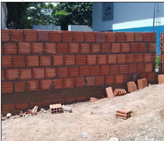
Imagem 4 - Muro do Cemitério São Francisco
