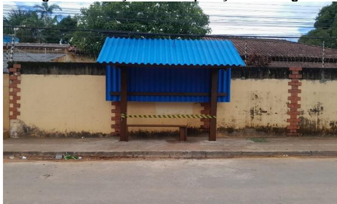
Figura 9. Serviços de recuperação de abrigos
