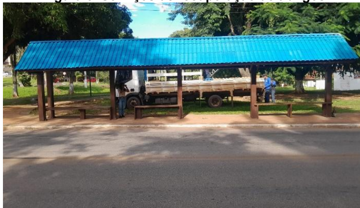
Figura 8. Serviços de recuperação de abrigos
