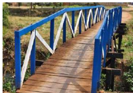
Passarela no Juarez Távora
