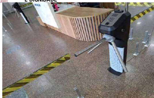
Instalação de catracas para registro de entrada e saída
