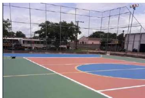
Manutenção Quadra Taquari
