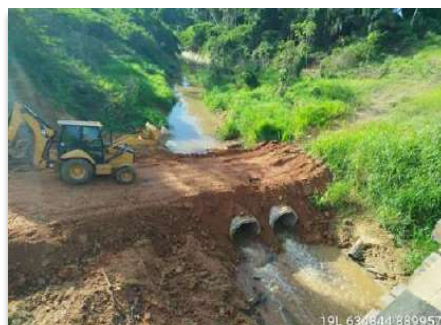
Intervenção de desvio do Igarapé para construção de ponte
