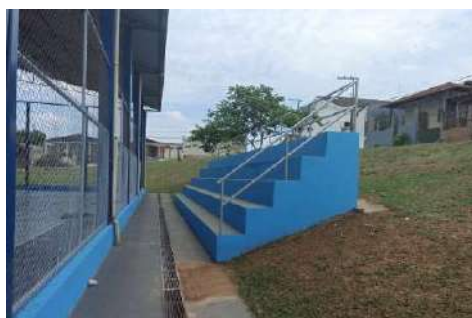
Manutenção arquibancada quadra Bela Vista
