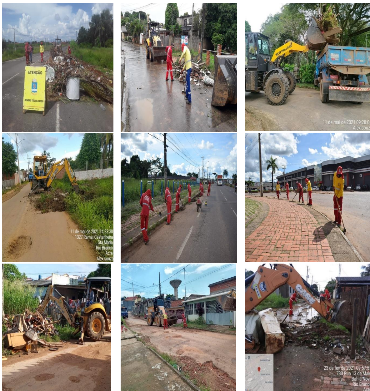
Figura 6 – Serviço de capina e retirada de entulhos
