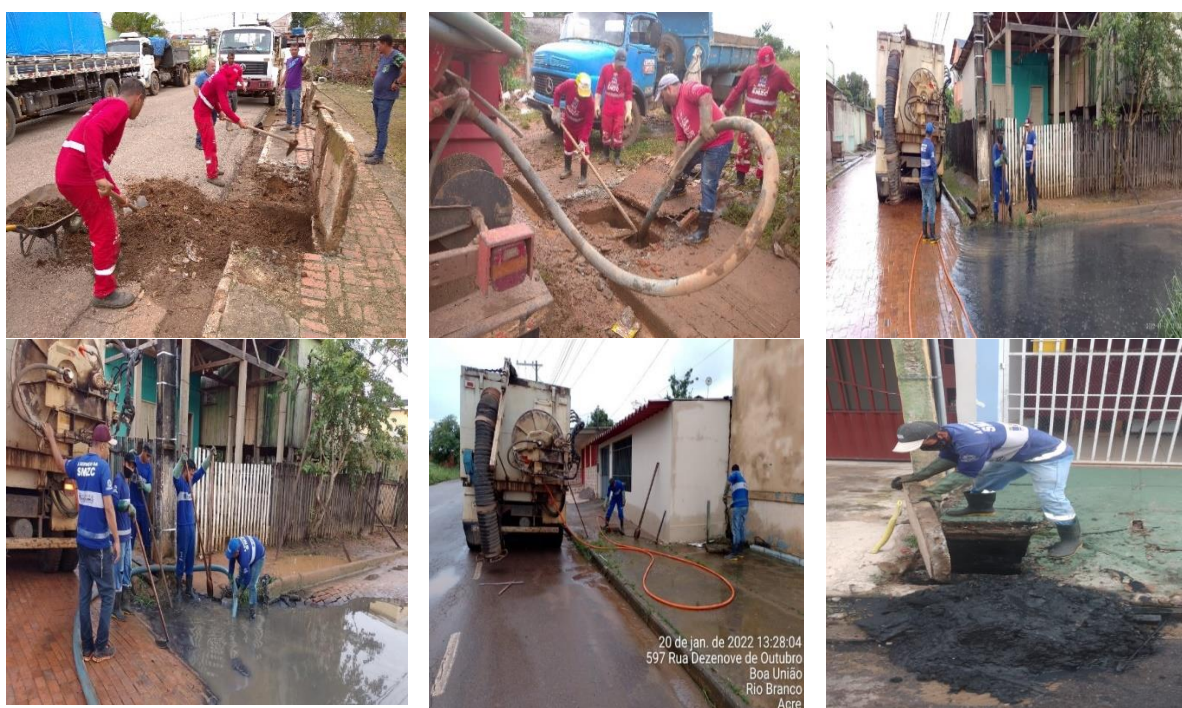
Figura 4 – Desobstrução manual de rede de drenagem de águas pluviais com retirada de entulhos
