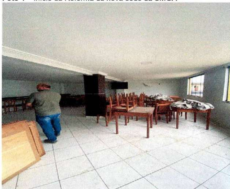
Foto 1 – Início da Reforma da nova sede da SMGA
