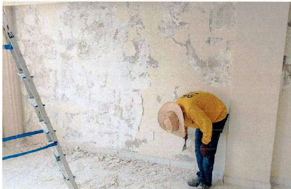
Foto 3 – Parede em reforma na nova sede da SMGA
