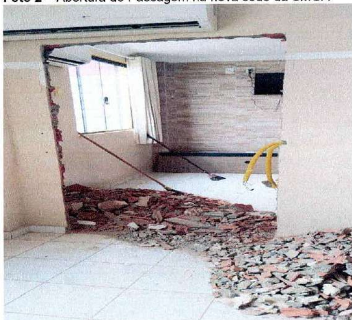
Foto 2 – Abertura de Passagem na nova sede da SMGA
