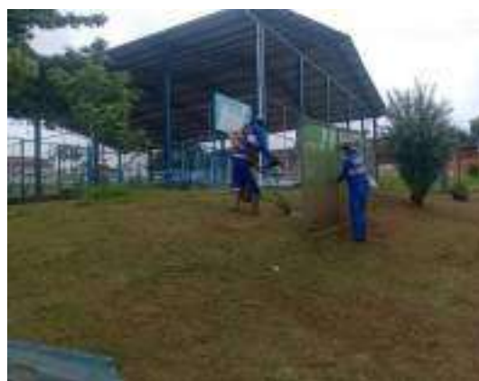
Imagem 98: Quadra poliesportiva - Conjunto Bela Vista
