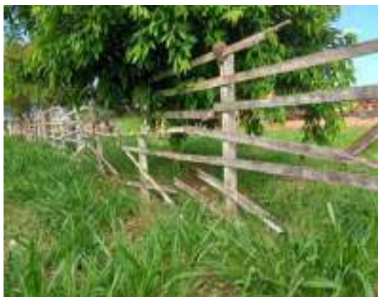
Imagem 445: Antes do Cercamento
