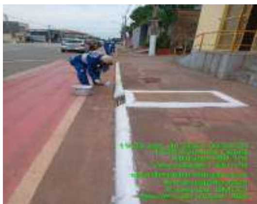
Imagem 33: Avenida Ceará - Caição
