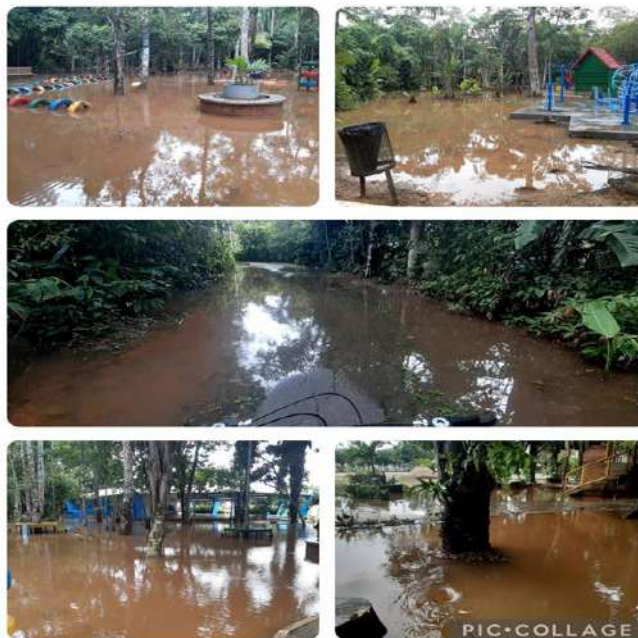
Figura 3. Acúmulo de água devido às chuvas e problemas de drenagem
