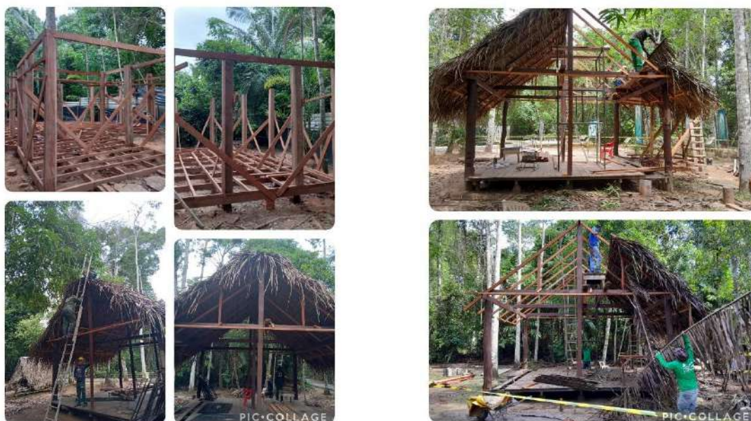
Figura 15. Reforma do Castelinho do playground do PACM
