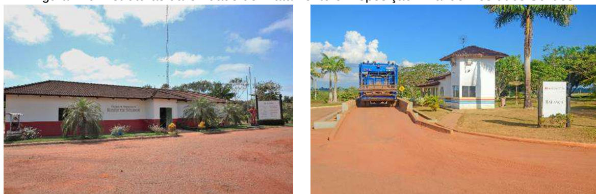
Figura 149. Estruturas da Unidade de Tratamento e Disposição Final de Resíduos Sólidos
