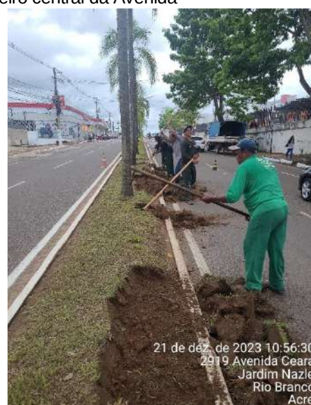
Figura 102. Nivelamento do canteiro central da Avenida
