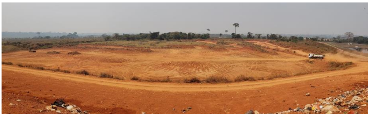
Figura 183. Área de futura implantação da 4ª célula de aterro sanitário.
