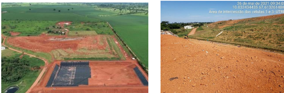
Figura 181. Operação da 2ª etapa da 3ª fase da célula de aterro sanitário de Rio Branco.
