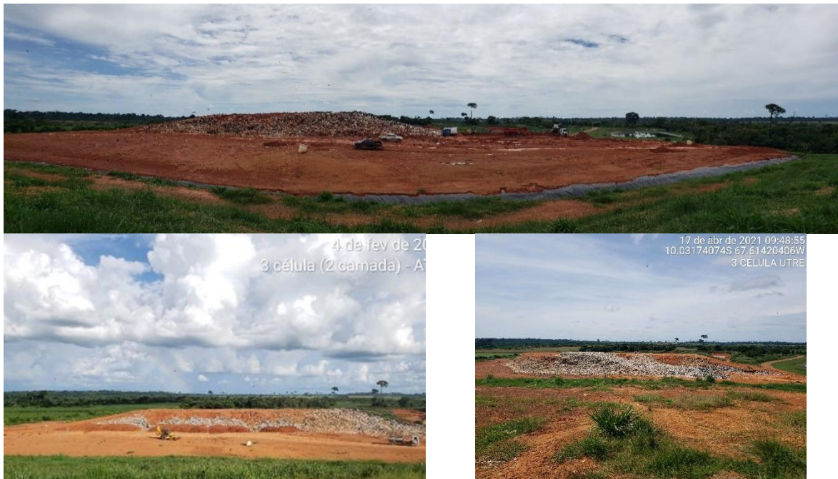
Figura 182. Evolução operacional da 2ª plataforma da 3ª fase da célula de aterro sanitário de Rio Branco instalado na UTRE.
