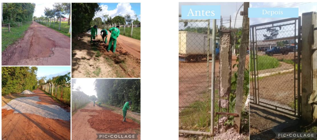
Figura 6. Reforma do acesso e do portão da saída principal do parque
