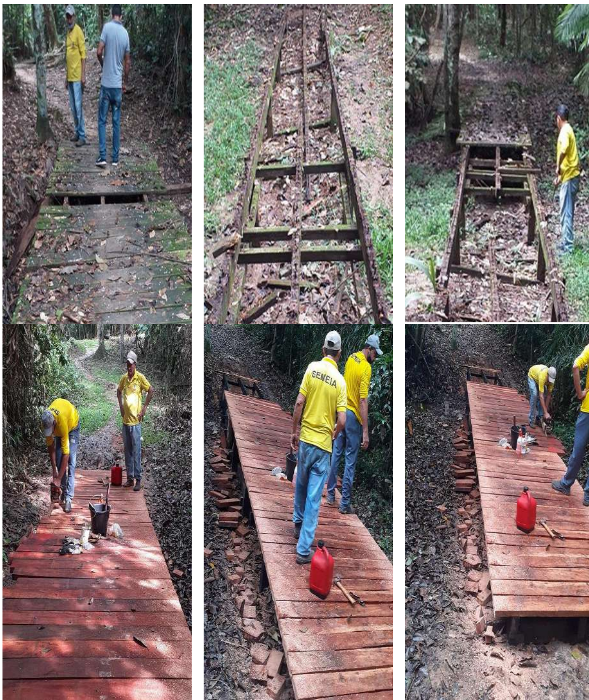
Figura 109. Construção de 2 pontes na trilha
