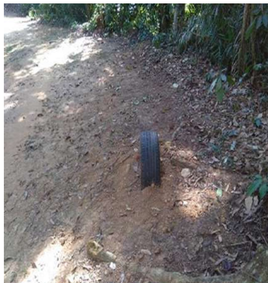
Figura 104. Limpeza, retirada de tocos, marcação com pneus abertura das laterais da trilha
