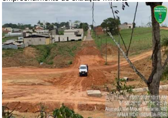
Figura 54. Fiscalização em áreas de loteamentos
