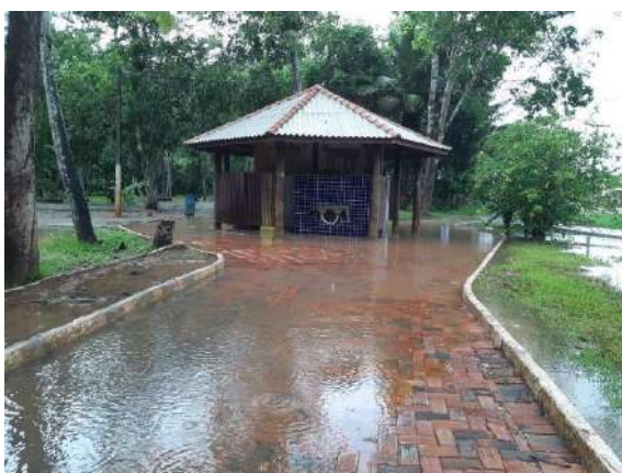
Figura 121. Registro dos problemas de drenagem e entupimento dos vasos sanitários do banheiro público do Parque Ambiental Chico Mendes
