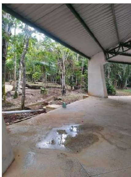
Figura 120. Registro da construção em andamento da Praça de Alimentação, evidenciando a goteira do telhado e a falta de acabamento do piso da construção da Praça de Alimentação do Parque Ambiental Chico Mendes.
