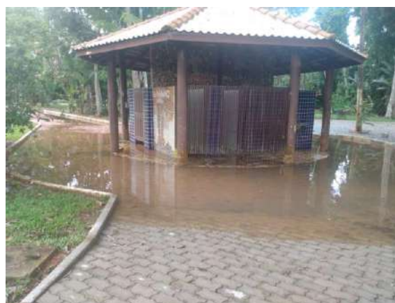
Figura 121. Registro dos problemas de drenagem e entupimento dos vasos sanitários do banheiro público do Parque Ambiental Chico Mendes
