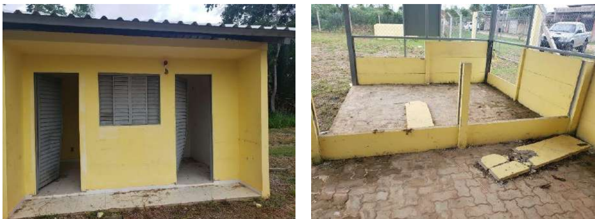
Figura 65. Estrutura do escritório administrativo do Ecoponto Conquista depreciado (portas, baias, telhado e cercamento) em novembro de 2021
