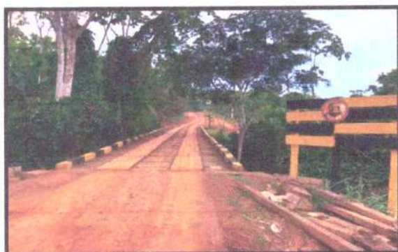
FOTO 13: PONTE ESTRADA DIAS MARTINS
