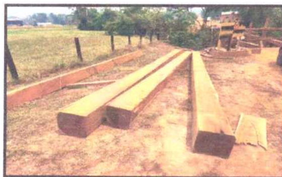
FOTO 09: PONTE ESTRADA DIAS MARTINS
