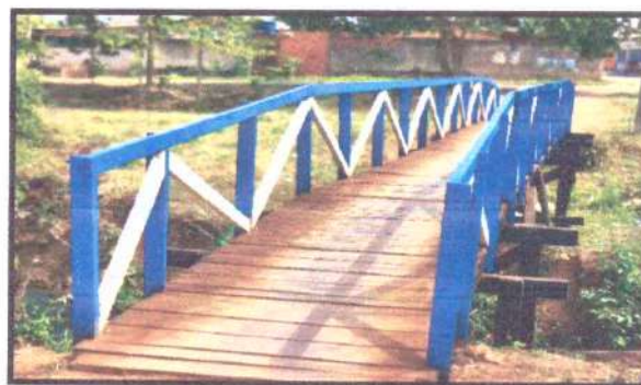
FOTO 02: PASSARELA JUAREZ TÁVORA
