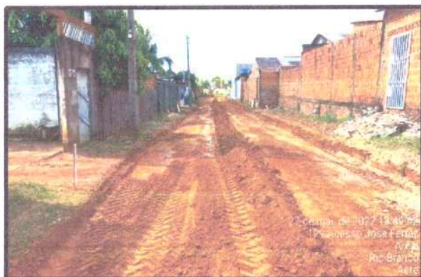
FOTO 01: RUA ANTÔNIO DE BRITO
