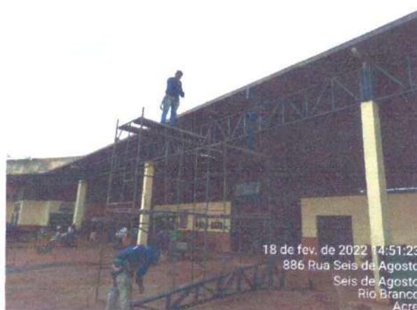
Pintura das Paredes da Sede da SEINFRA
