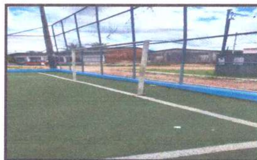
Reparo da Rede De Proteção Concluído
