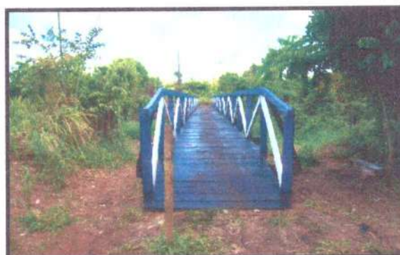
FOTO 14: PASSARELA DO TAQUARI
