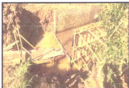
FOTO 05: RUA SÃO JOÃO
