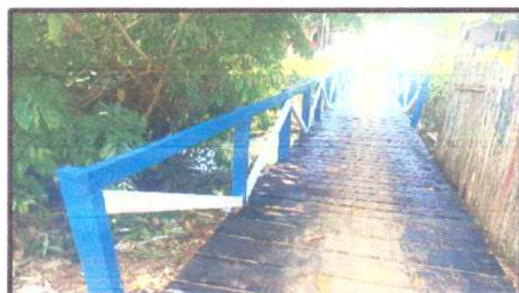
FOTO 13: PASSARELA DO BAIRRO GERALDO FLEMING
