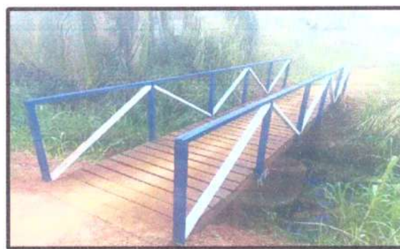
FOTO 04: PASSARELA NOVA ESPERANÇA
