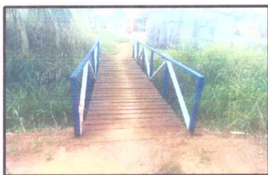
FOTO 03: PASSARELA NOVA ESPERANÇA
