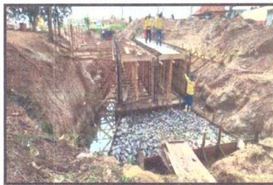
FOTO 06: RUA SÃO JOÃO
