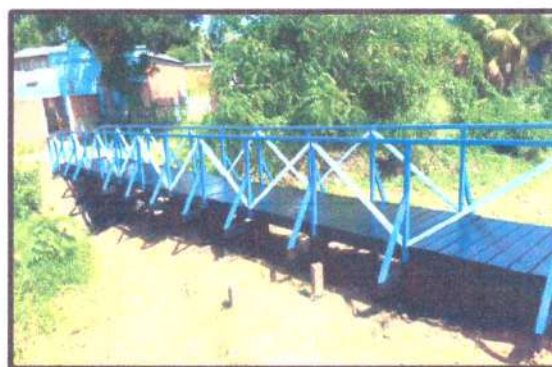
FOTO 12: BECO DA TRIPA III
