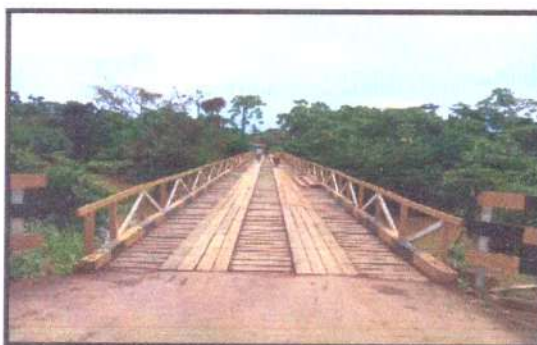
Ponte do Igarapé Judia Entre Canaã e Belo Jardim
