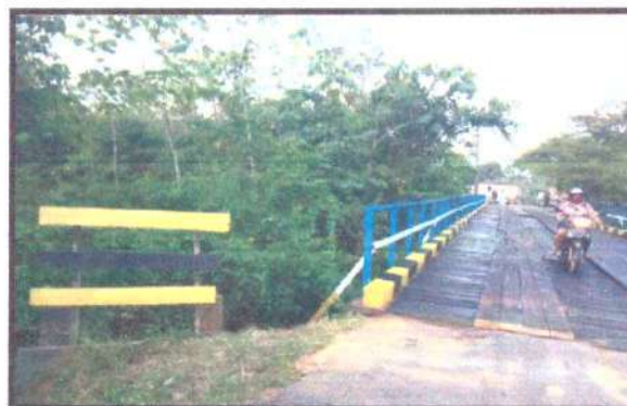
FOTO 06: PONTE DO TAQUARI
