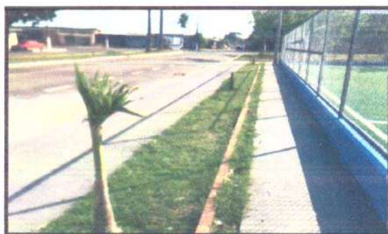
FOTO 01: CALÇADA - CIDADE NOVA
