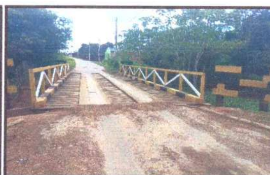
Ponte do Ramal do Castanheira
