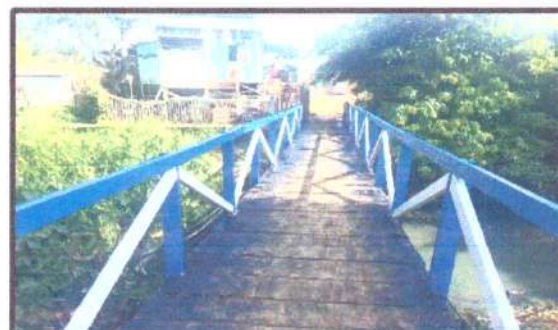
FOTO 14: PASSARELA DO BAIRRO GERALDO FLEMING
