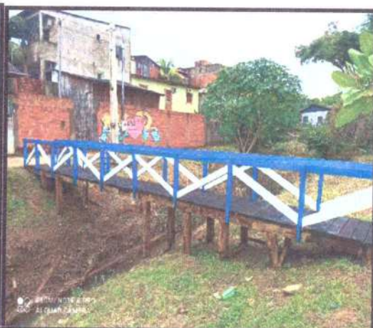
Passarela do Nova Estação - Próximo a Escola
