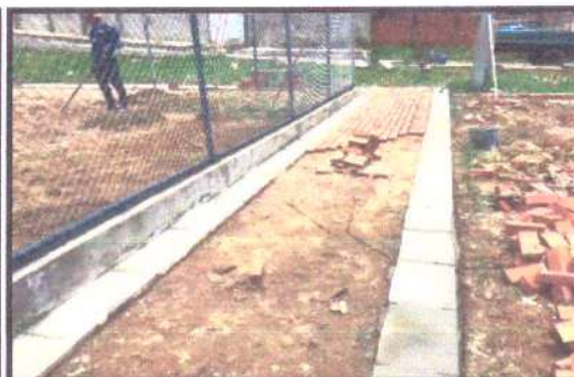
Pintura da Mureta da Quadra
