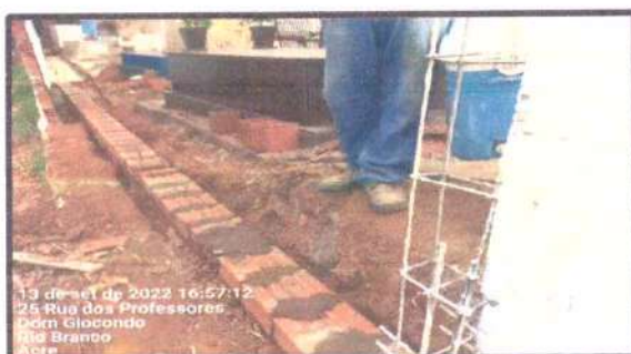
FOTO 07: MURO DO CEMITÉRIO SÃO JOÃO BATISTA
