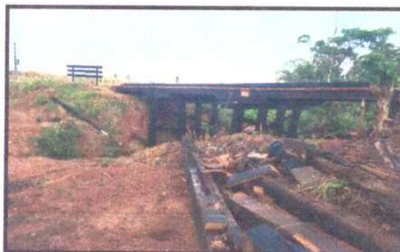
FOTO 11: PONTE QUIXADÁ - IGARAPÉ REMANSO
