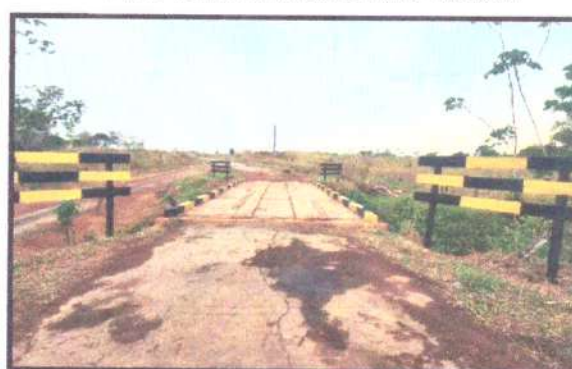
FOTO 12: PONTE QUIXADÁ - IGARAPÉ REMANSO
