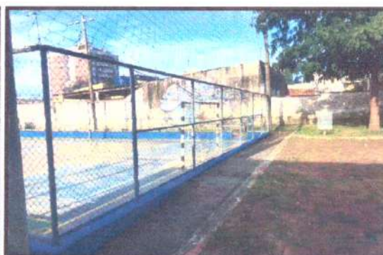
Pintura da Mureta da Quadra
