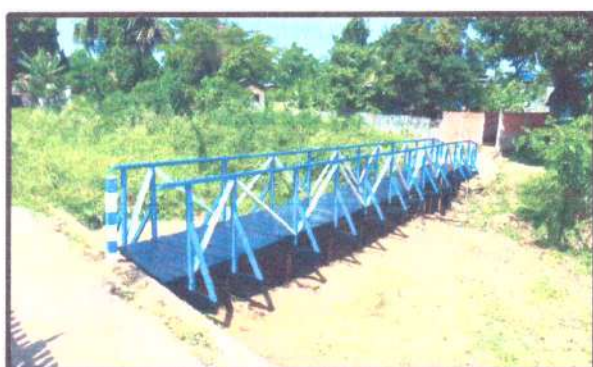
FOTO 11: BECO DA TRIPA III
