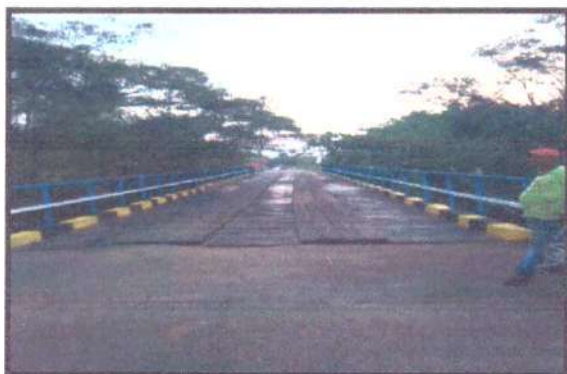
FOTO 05: PONTE DO TAQUARI
