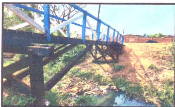
FOTO 01: PASSARELA JUAREZ TÁVORA
