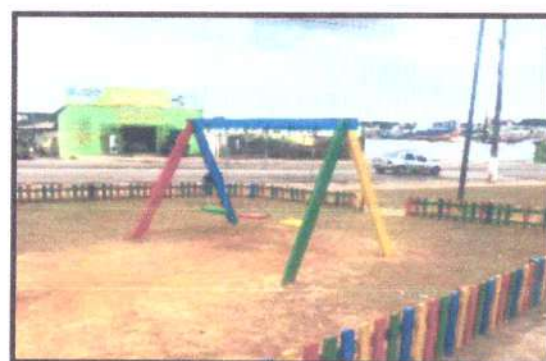
Manutenção do Playground
