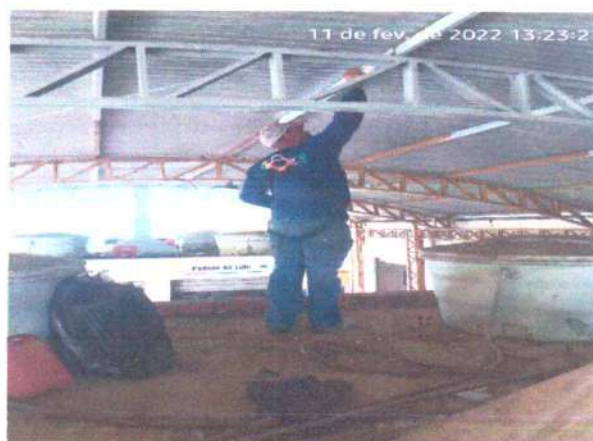
Execução de Pintura na Estrutura Metálica do Mercado AZIZ ABUCATER
