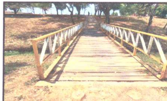
FOTO 10: PASSARELA BAIRRO TUCUMÃ
