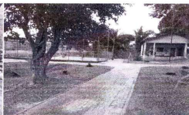
foto 68 – execução da calçada
