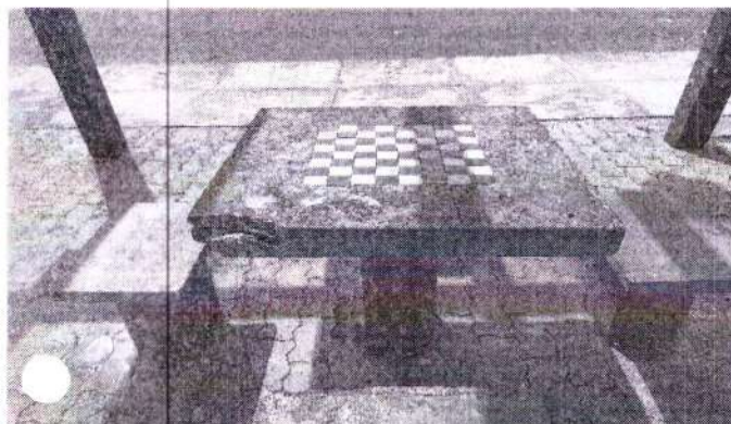
Foto 97 –mesa danificada e com desgaste na pintura
