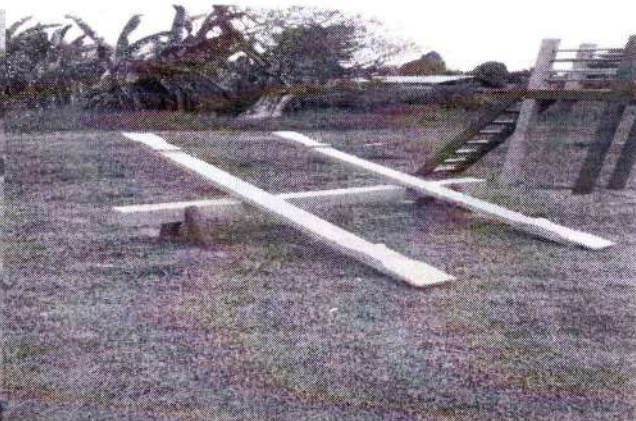
foto 118 – reforma e pintura do parquinho
