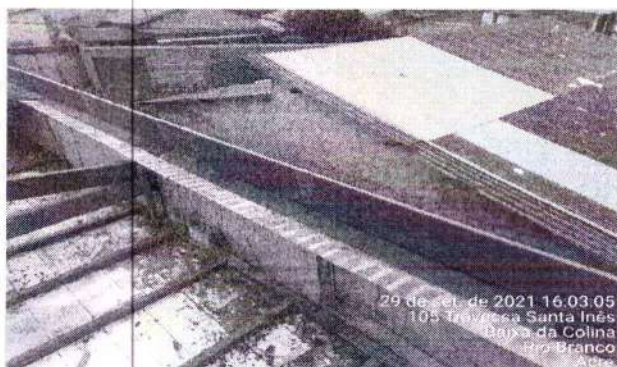
Foto 06 - Telhamento Com Telha De Fibrocimento (Arquivo Seinfra)
