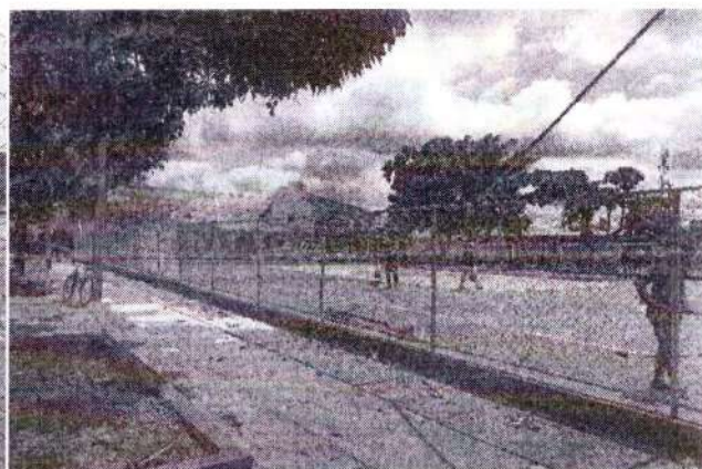
foto 96 – execução da reforma do alamedado
