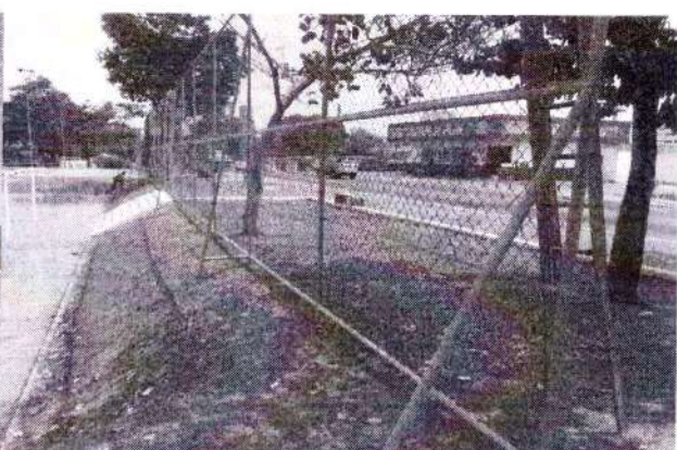
foto 28 –alambrado depois da reforma
