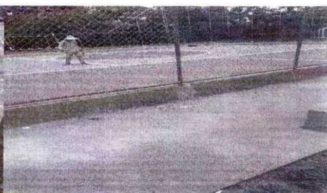
foto 104 –reforma do alambrado e da mureta
