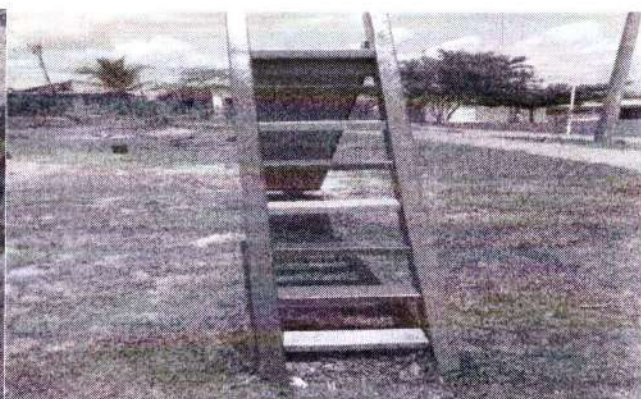
foto 126 – reforma e pintura do parquinho
