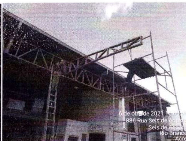
Foto 26- Remoção De Tesoura Metálica Mercado 06 De Agosto
