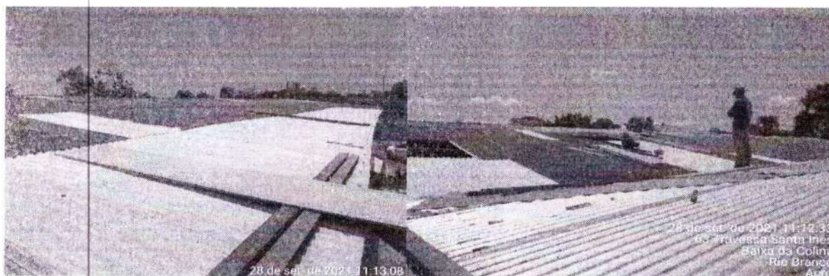
Foto 7 – Telhamento Com Telhas De Fibrocimento
