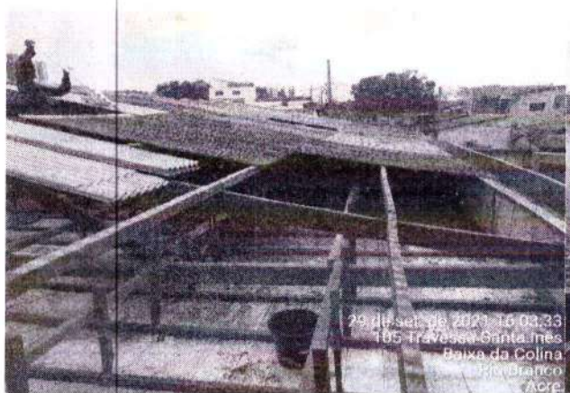
Foto 03 - Remoção De Telhas (Arquivo Seinfra)
