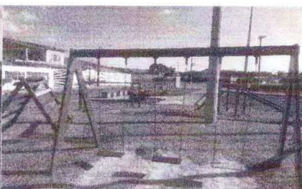
foto 40 – pintura do parquinho
