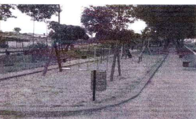
foto 62 – execução da pintura do parquinho
