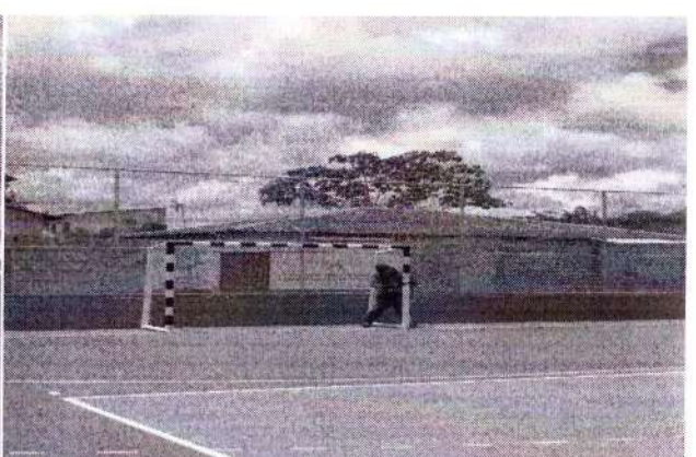
foto 110– execução da pintura da quadra
