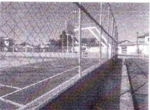
foto 36 – alambrado e pintura da mureta
