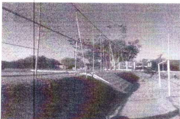
Foto 27 –alambrado antes da reforma
