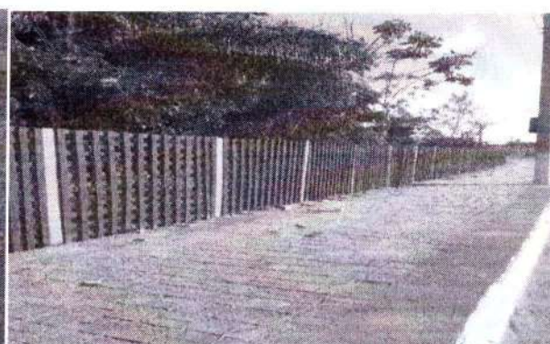
foto 134– execução e pintura da cerca
