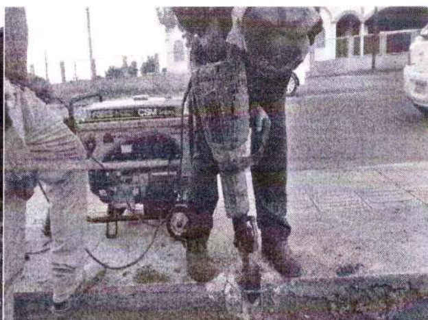
Foto 28 - Demolição De Estrutura De Concreto (Muro)
