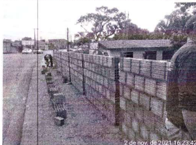
foto 29 -30- execução de alvenaria (muro)
