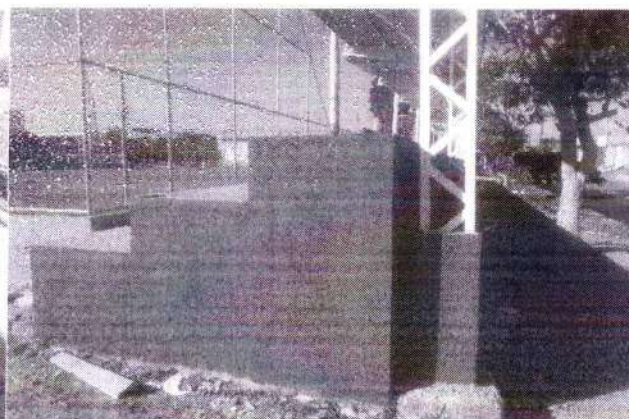
foto 14 – execução da pintura da arquibancada
