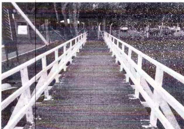
Foto 57 – execução da pintura do guarda corpo
