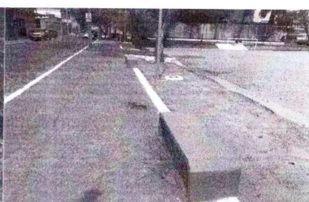
foto 24 – execução da pintura dos bancos
