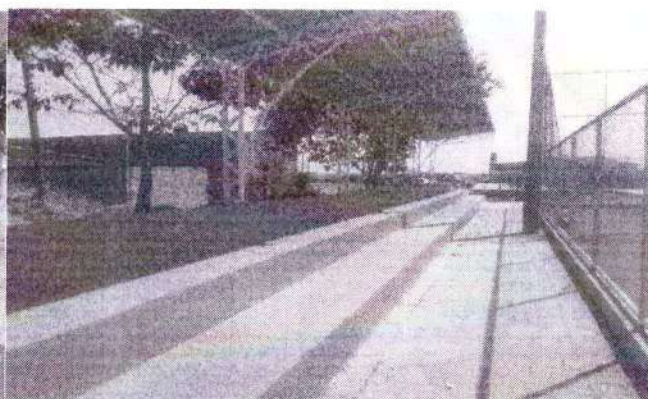
Foto 11 –arquibancada antes da reforma
