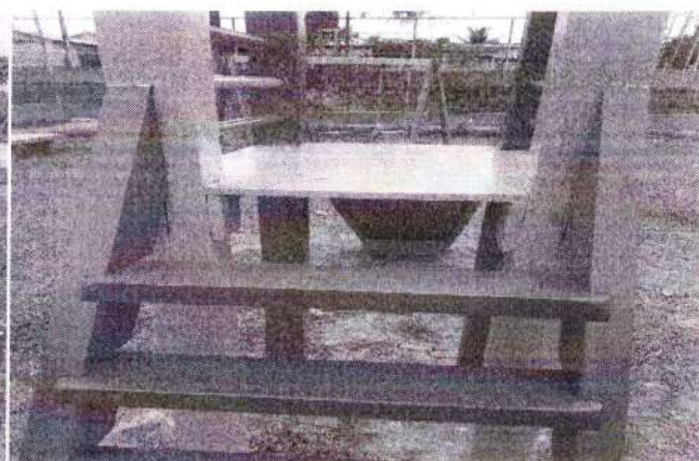
foto 128 – reforma e pintura do parquinho
