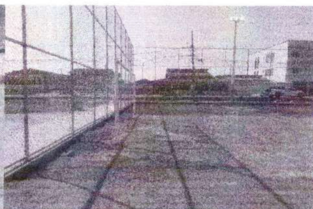
foto 16 –alambrado depois da reforma
