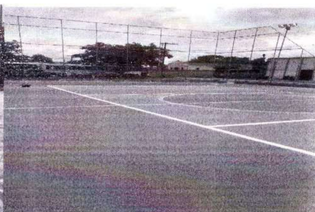
foto 106 – execução da pintura da quadra
