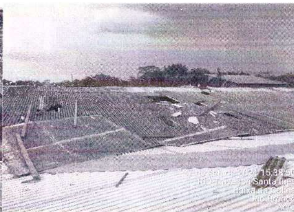
Foto 02 - Remoção De Telhas (Arquivo Seinfra)
