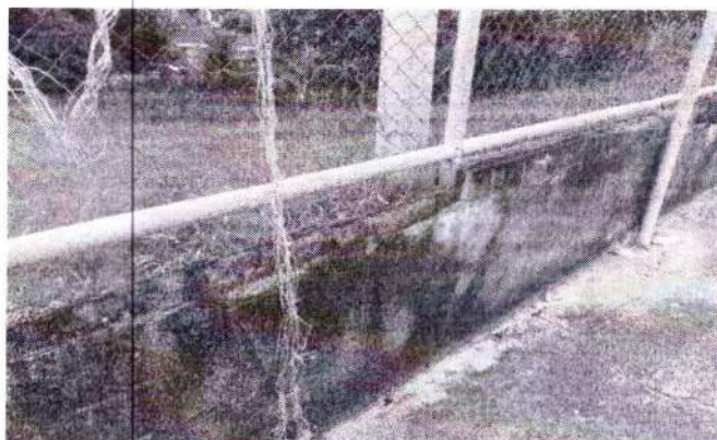
Foto 107 –mureta da quadra antes da reforma
