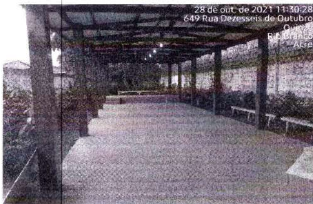
Foto 21 - pintura de piso centro cultural nenem sombra
