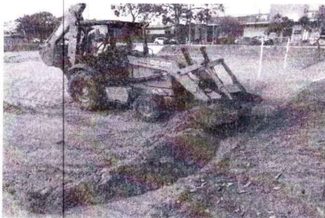
Foto 31 –regularização do campo de areia
