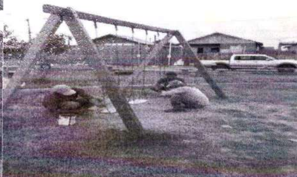
foto 130 – reforma e pintura do parquinho
