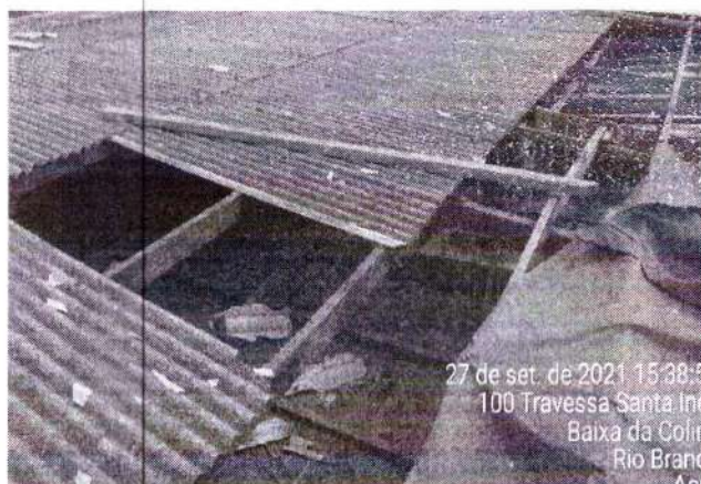
Foto 01 - Remoção De Telhas (Arquivo Seinfra)
