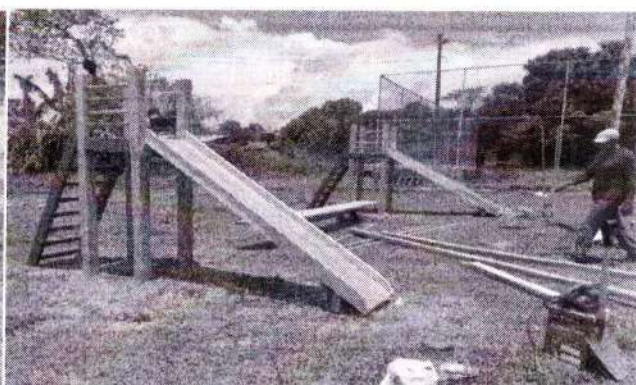
foto 120 – reforma e pintura do parquinho
