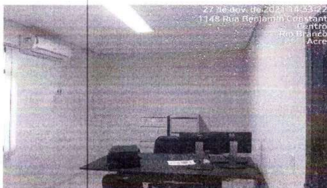
Foto 35 – Pintura De Paredes
