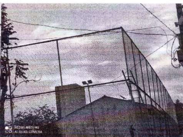
foto 90 – execução da reforma do alambrado
