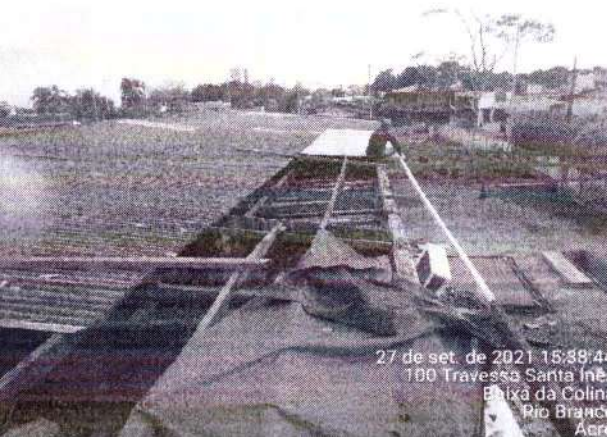
Foto 04 - Execução De Trama De Madeira (Arquivo Seinfra)
