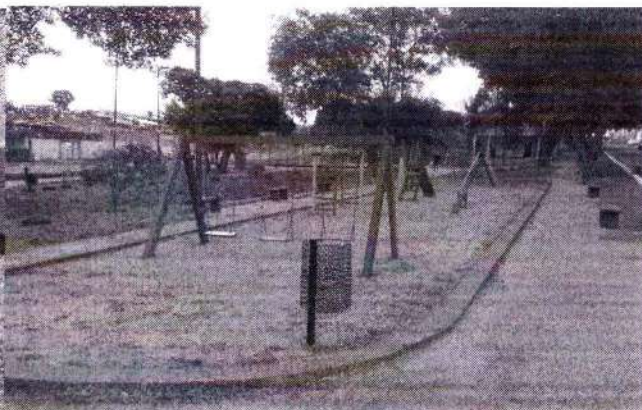
foto 64 – execução da pintura do parquinho
