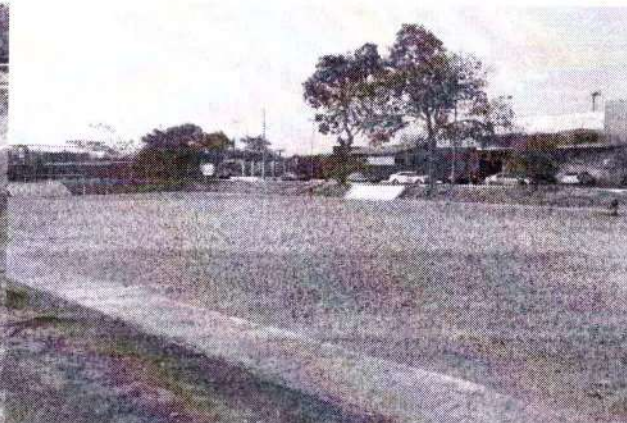
foto 32 – regularização do campo de areia
