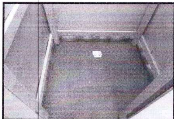
FIGURA 18 – Detalhe Piso Com Ralo
