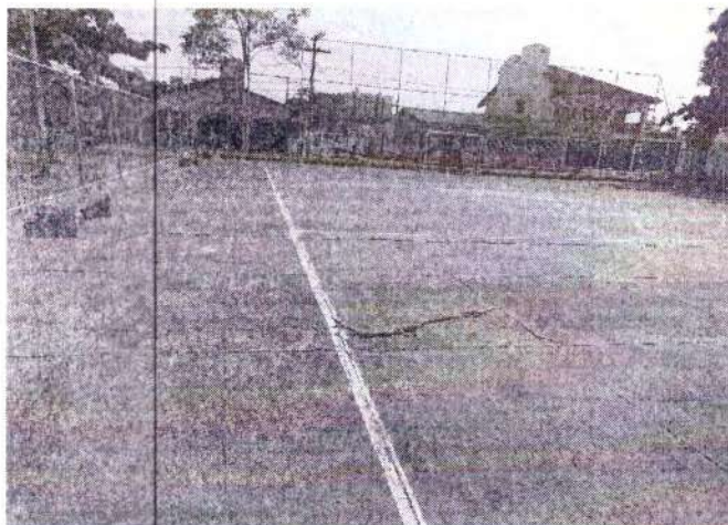
Foto 93 –quadra antes da reforma
