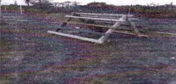
foto 132– reforma e pintura do parquinho
