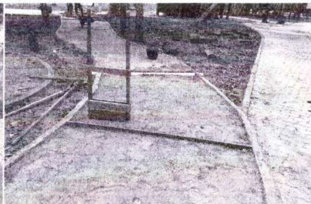
foto 52 – execução e pintura da calçada
