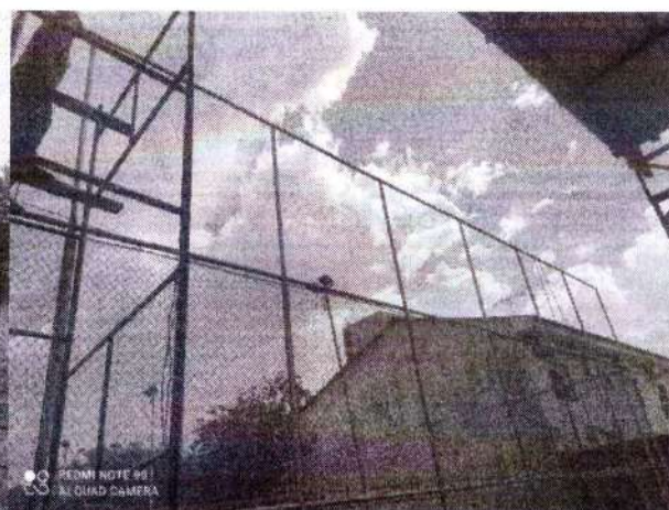
foto 92 – execução da reforma do alambrado
