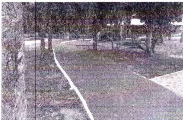
Foto 51 – execução da calçada
