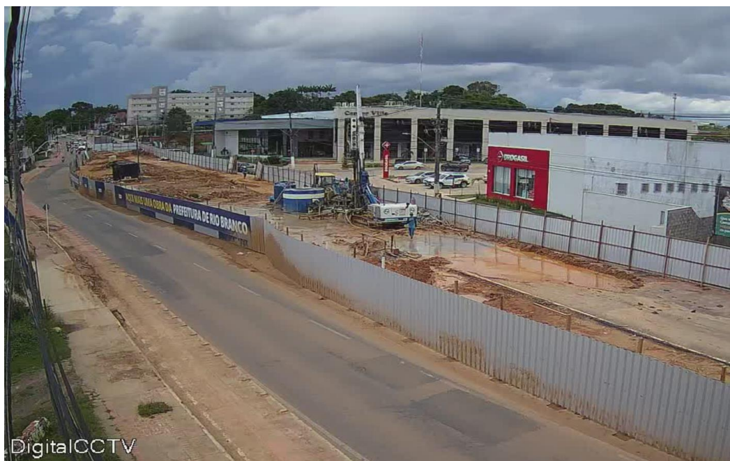
Figura 18. Imagem da câmera construção do Elevado Dias Martins.
