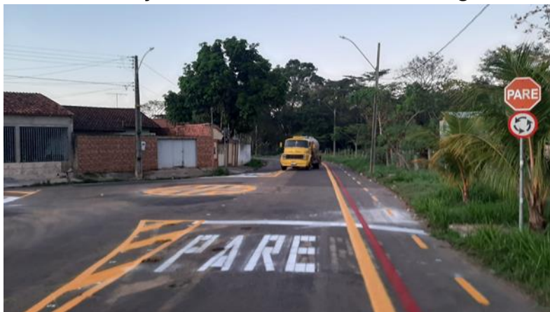
Figura 10. Foto da sinalização da ciclovía na Avenida Eugênio Beto Bezerra.
