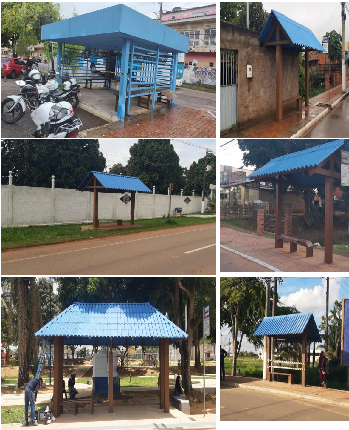
Figura 15. Serviços de recuperação de abrigos
