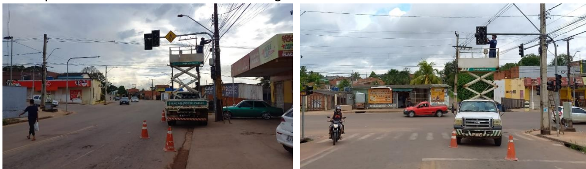
Figura 9. Serviço de melhoria do semáforo em frente à Escola Glória Perez.
