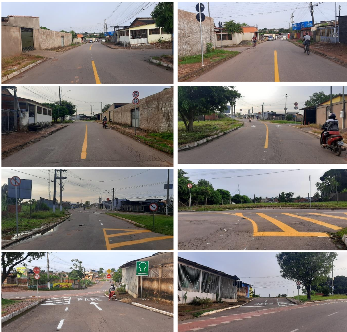
Figura 2. Fotos da sinalização no acesso da Rua Juarez Távora.
