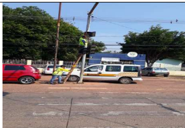
Figura 10– Rodovia Ac 40 (manutenção do semáforo)
