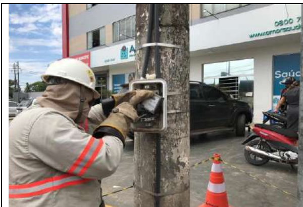
Figura 09- Av. Getúlio Vargas (troca de medidor de energia)
