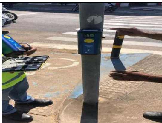
Figura 07 - Rua Quintino Bocaiuva – (Instalação de botoeiras)
