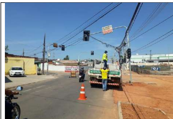
Figura 11- Rua Isaura Parente (próximo ao SESI) retirada do semáforo
