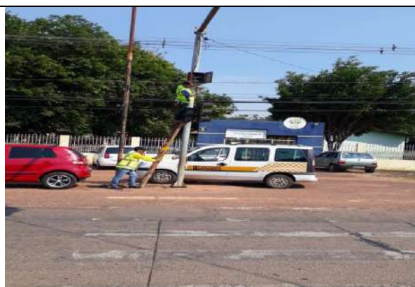
Figura 08– Rodovia Ac 40 (manutenção do semaforo)
