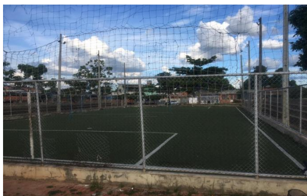
Figura 85 - Em manutenção - Quadra do João Eduardo
