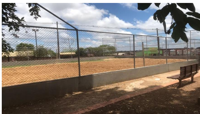
Figura 94 - Em manutenção - Quadra da Betel
