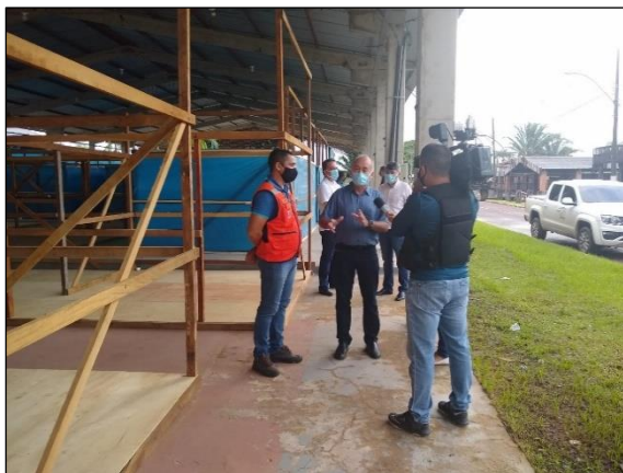
Construções dos módulos no Parque de Exposição
