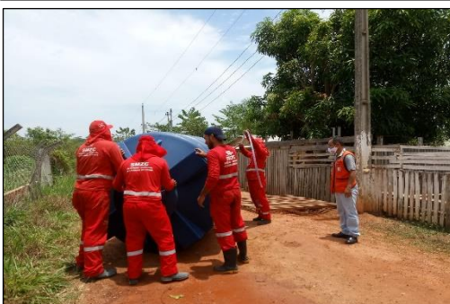
Colocação da caixa d'água no terreno
