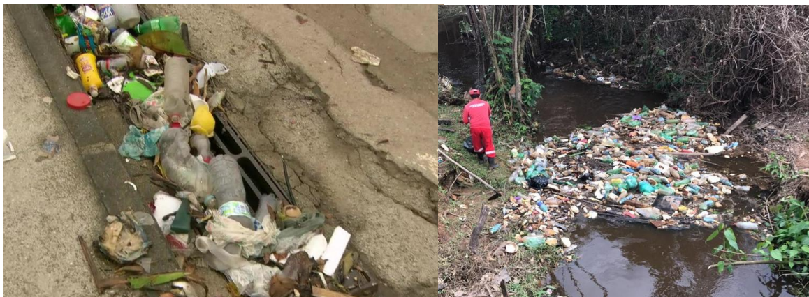
Figura 20 – Lixo acumulado em local de escoamento atrapalhando o fluxo de águas pluviais.
