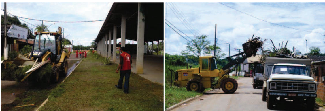
Figura 10 – Serviços executados na “Ação de Inverno”.
