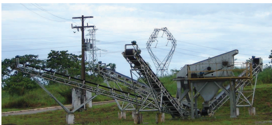
Figura 37 – Unidade recicladora de resíduos da construção civil de Rio Branco.
