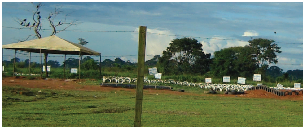
Figura 23 – Valas sépticas localizadas na UTRE.
